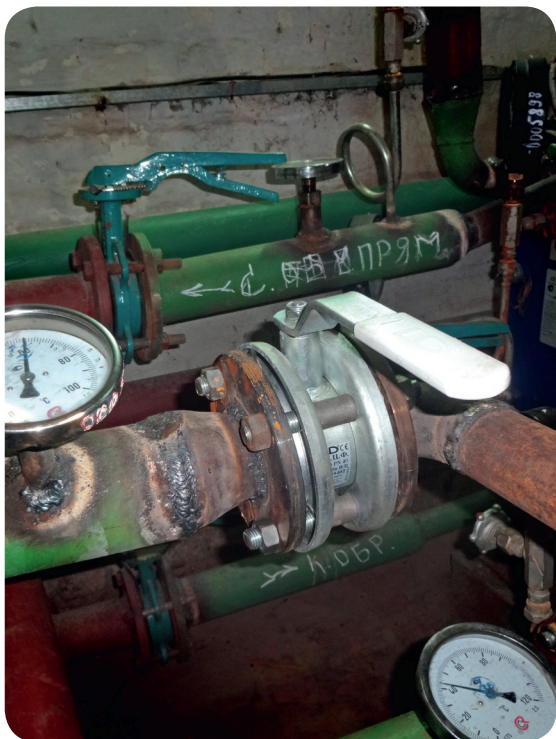
ТЕПЛОПУНКТ (ОБВЯЗКА ТЕПЛООБМЕННИКА)
