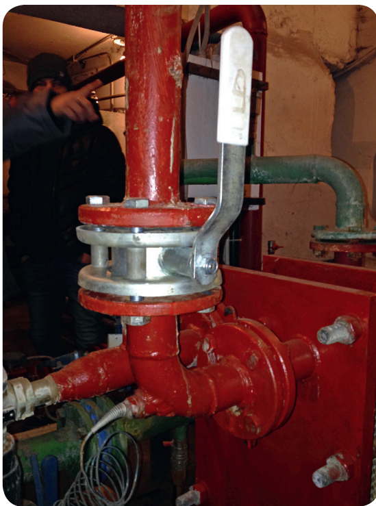
КОНТУР ГВС ПОСЛЕ ПЛАСТИНЧАТОГО ТЕПЛООБМЕННИКА
